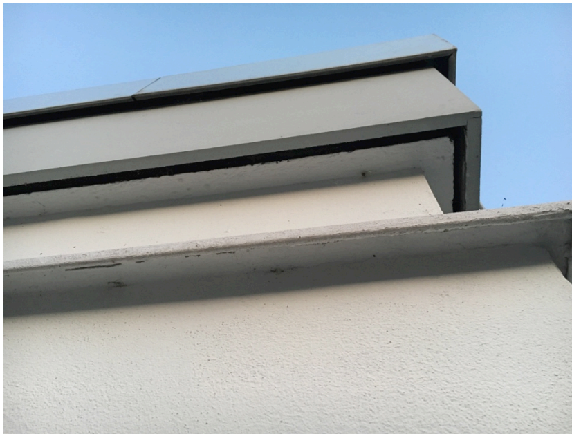
Abb. 6: Beispiel für mögliches Spaltenquartier
