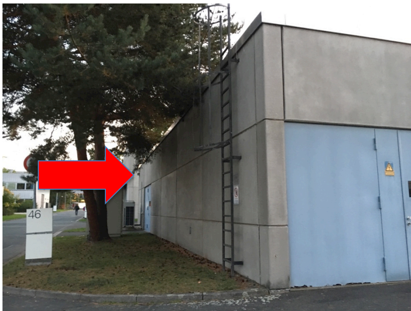
Abb. 7: Bau 46: Hinweis auf Fledermausbesatz hinter Traufverkleidung auf der Ostseite des Gebäudes (Lage angezeigt durch roten Pfeil)
